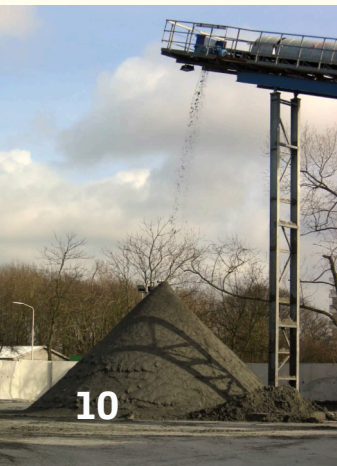
Boren van de Hubertustunnel.
